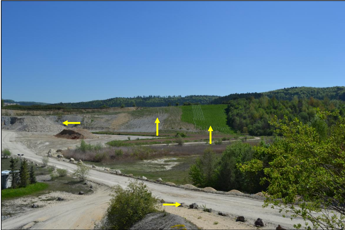
Foto3 - Visão da área de extração, dos taludes recuperados e em recuperação. Detalhe para os blocos de grande dimensão formando as leiras de proteção e auxiliando no direcionamento do trânsito nas vias internas.
